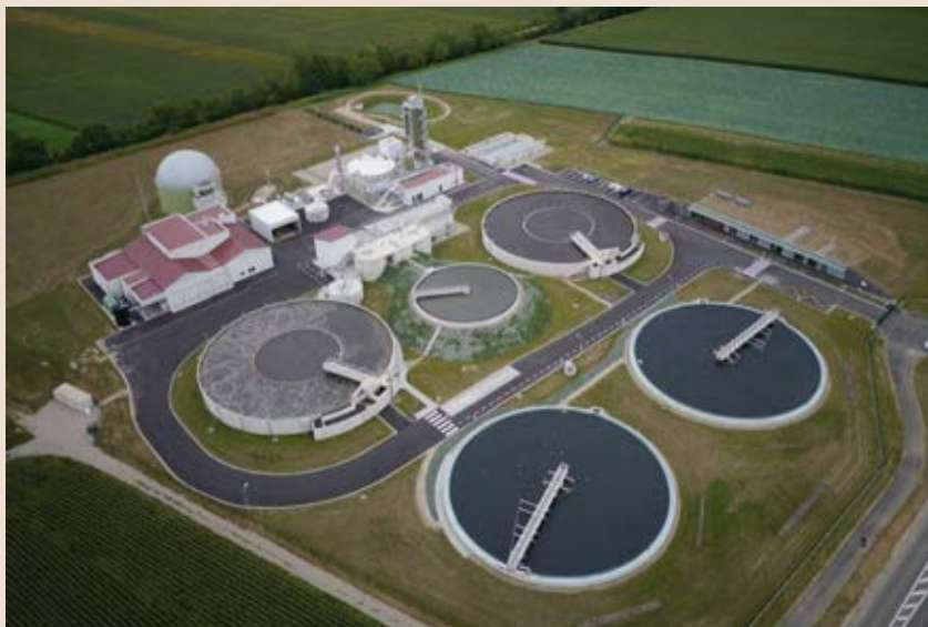
Станция по очистке воды Suez Environment в Меистрацхейме, Франция. Фото © J. Voccon-Gibon
