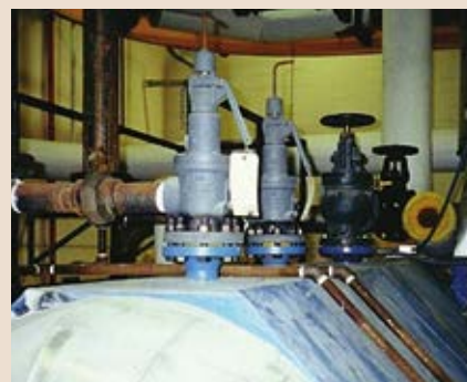
Рис. 1. Огневую трубу парогенератора защищают два предохранительных клапана.
