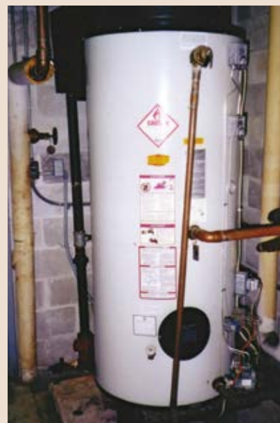
Рис. 10. Клапаны, срабатывающие по заданной температуре или давлению, защищающие водонагреватель
