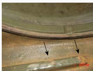
Коррозия направляющей первого диска
