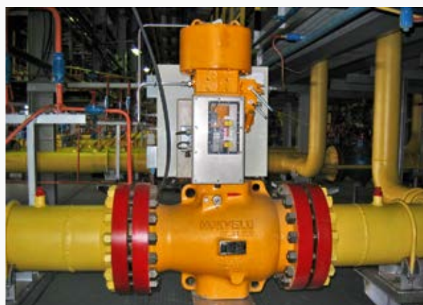
Рис. 9. Общий вид клапана Моквелд
