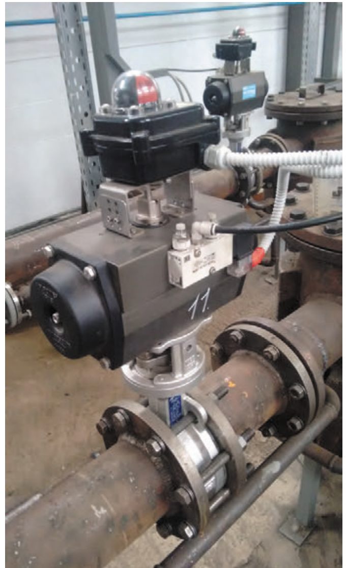
Затвор поворотный дисковый с пневмоприводом и распределителем
