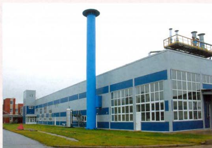
Общий вид производственного и административно-бытового корпуса нового участка по ремонту и ревизии арматуры
