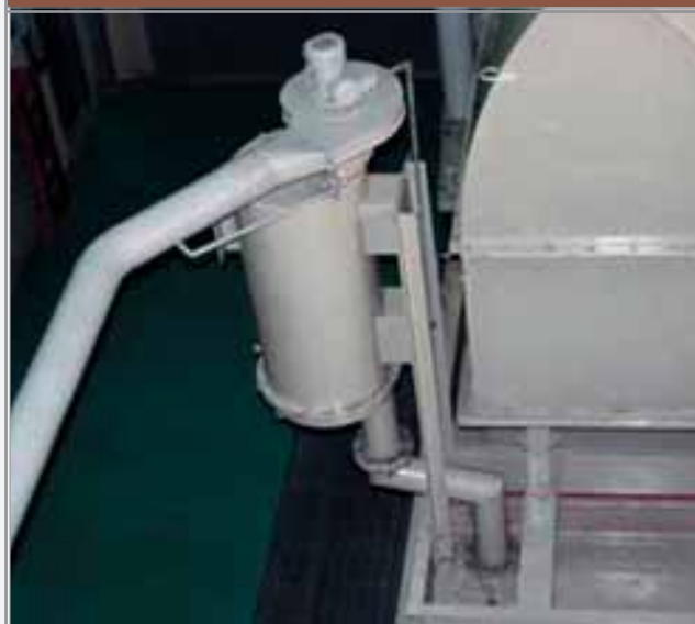
Рис. 2. Фильтр-сепаратор после модернизации
