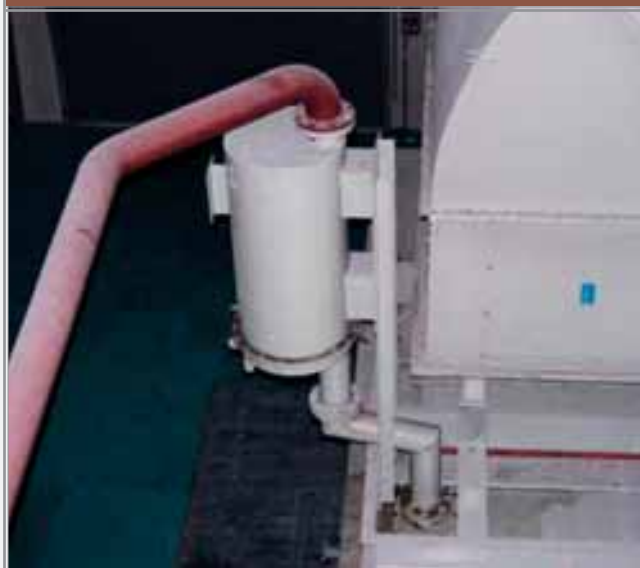
Рис. 1. Фильтр-сепаратор до модернизации
