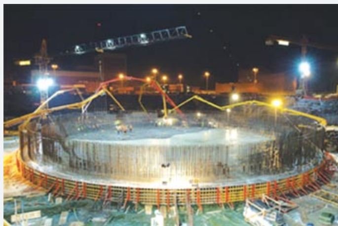
Строительство новой АЭС поколения III+ мощностью 1,6 ГВт в Олкилуото, Финляндия. (Рисунок из журнала «В мире науки» №1-2007, сайт http://www.sciam.ru )
