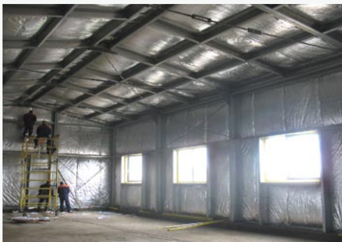
Заканчивается отделка нового цеха в Балабаново
