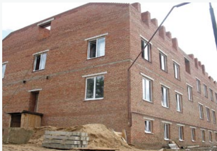
Строительство нового офиса в Балабаново
