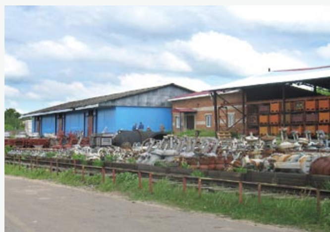
Склад арматуры в Балабаново
