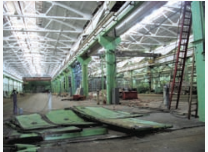
Цеховой пролет, освобожденный под новое оборудование
