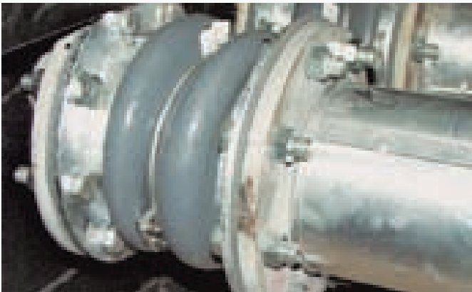
Использование резинокордового компенсатора на судовой установке
