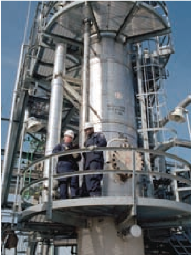
Нефтеперерабатывающий завод Marathon, Детройт. Фото: © Marathon
