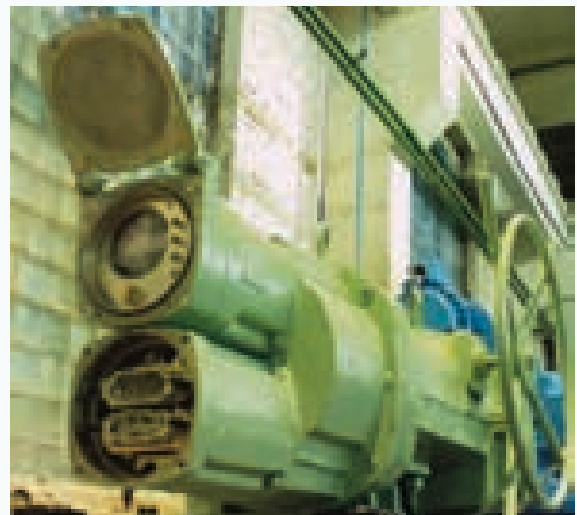
Рис. 6. Электропривод серии ЭП4 для атомных электростанций с разъемами для подключения диагностических средств АСУ ТП
