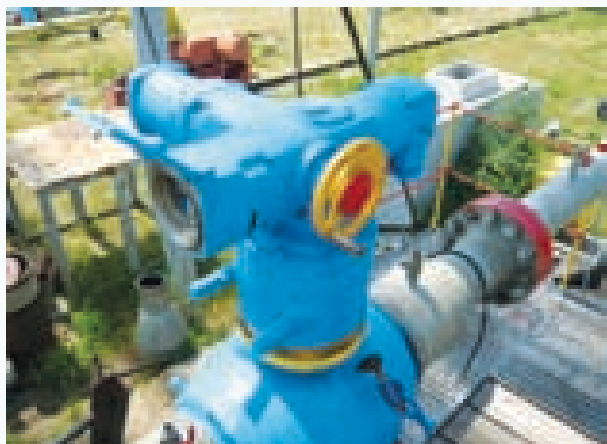
Рис. 9. Неполнооборотный электропривод на базе многооборотного привода ЭП4 и редуктора серии РН
