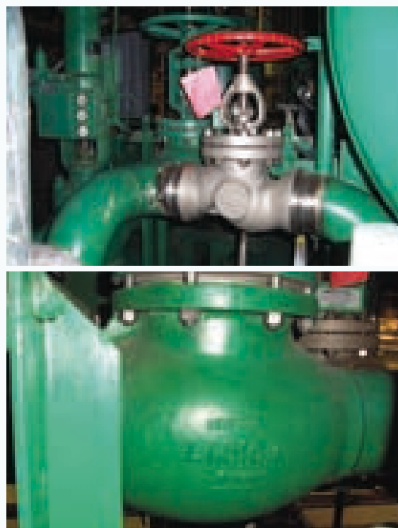
Рис. 1. Поддельный (вверху) и настоящий (внизу) клапаны, обнаруженные на атомной станции на юго-востоке США. Один контрафактный клапан был уже установлен в системах внешнего контура энергоблока; другой обнаружен на складе
