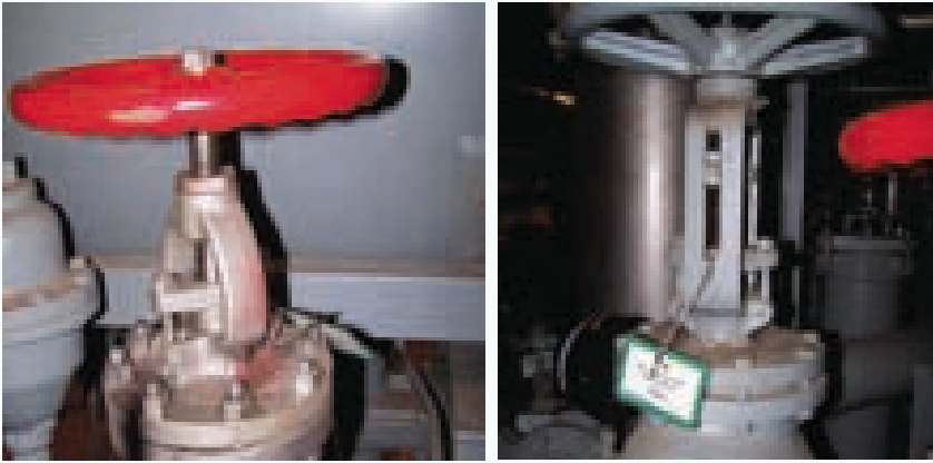
Рис. 3. Слева – контрафактный клапан с красным маховиком; законно выпущенный клапан справа – с маховиком серого цвета. Разница очевидна только опытному глазу, и ничего не подозревающий контролер может ее просто не заметить
