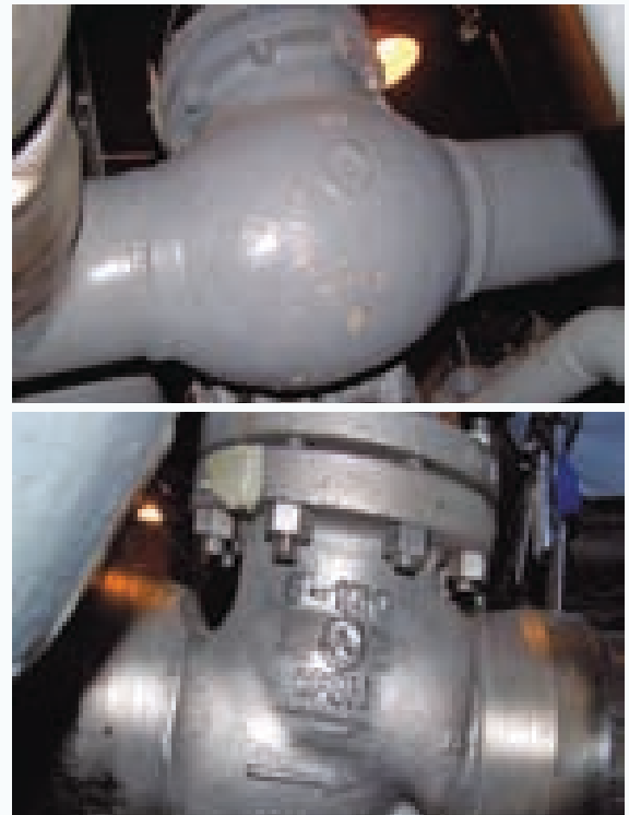
Рис. 2. Настоящий (вверху) и поддельный (внизу) клапаны. Логотип «L» на корпусе контрафактного клапана появился позже с помощью сварки (вместо отливки вместе с корпусом) и «обработан» полированием
