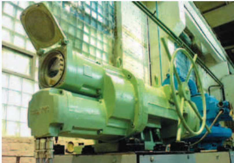
Рис. 3. Привод ЭП4 для АЭС 8000 Нм, 22 об/мин, исполнение – для помещений, с интеллектуальным модулем управления
