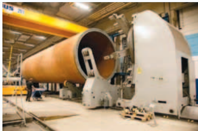
Рис. 6. Установка для сварки мачт для ветряных электрогенераторов
