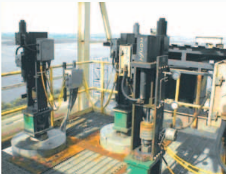
Компания АЕР (American Electric Power) установила два клапана с антикавитационными затворами в ходе модернизации байпасной системы на котлах 1 и 2 своей станции «Джон. Е. Амос»
