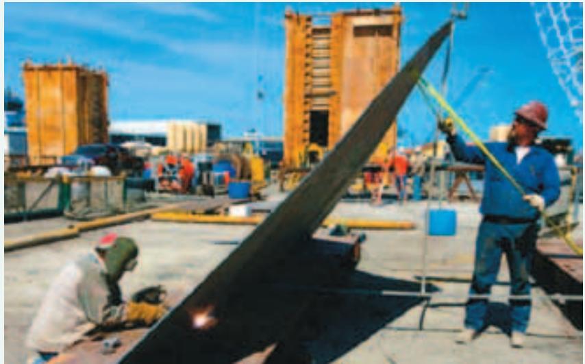
Работы по строительству конструкции по сбору нефти под водой, разработанной для сдерживания разлива нефти в Мексиканском заливе. Фото © ВР Р.С.
